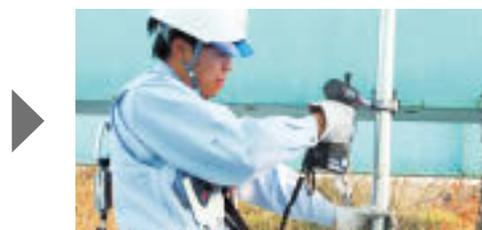
フレ止め単管を橋梁に取り付ける。
