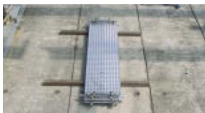
開閉床材を閉じ、両端部のパネル内蔵高ナットにSPパネル用単クランプボルト付を取り付け単管と自在クランプを設置する。
