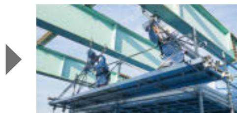
単管に設置した自在クランプにフレ止め単管を取り付け、パネル設置高さまでゆっくり降ろす。
