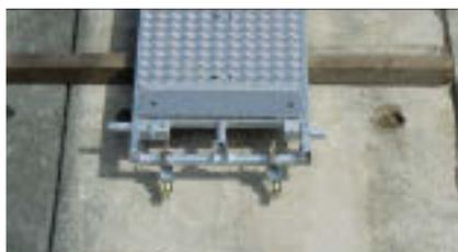
開閉床材を開きSPパネル用平行クランプ、又はSPパネル用平行カバーを取付ける。
