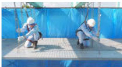
設置するパネルを手前に引きパネルを接合した後、連結ボルトBで固定します。
