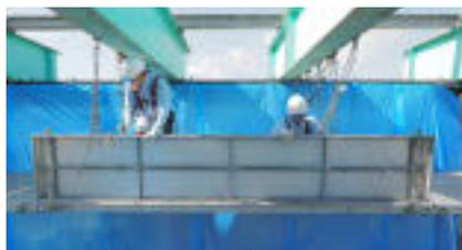
橋梁に吊りチェーン用クランプを取り付けチェーンを吊りチェーン用クランプ、パネルの吊りリングに設置し、設置するパネルを既設パネルの受け金具の上に仮置きする。
