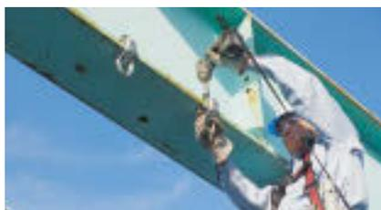
橋脚もしくは足場の上に上がり、橋梁に吊りチェーン用クランプ、鉄骨用クランプを取り付け、チェーンを吊りチェーン用クランプとパネルに設置した単管に取り付ける。
