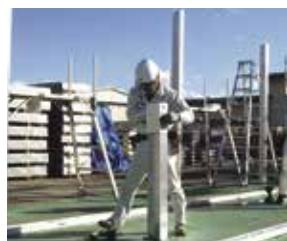
打ち込んだ杭注に柱頭金物を付属のボルト・ナットで取付けます。
