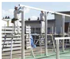
後方支柱にも金物を取り付け、梁材を柱頭金物の高さまで持ち上げて固定します。
