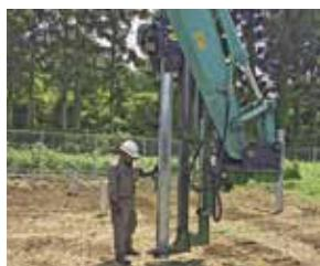
バックホーに杭注をセットし、地面への垂直調整後打ち込みます。
