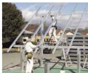
梁材と直角に根太材を取付けて架台の完成です。
