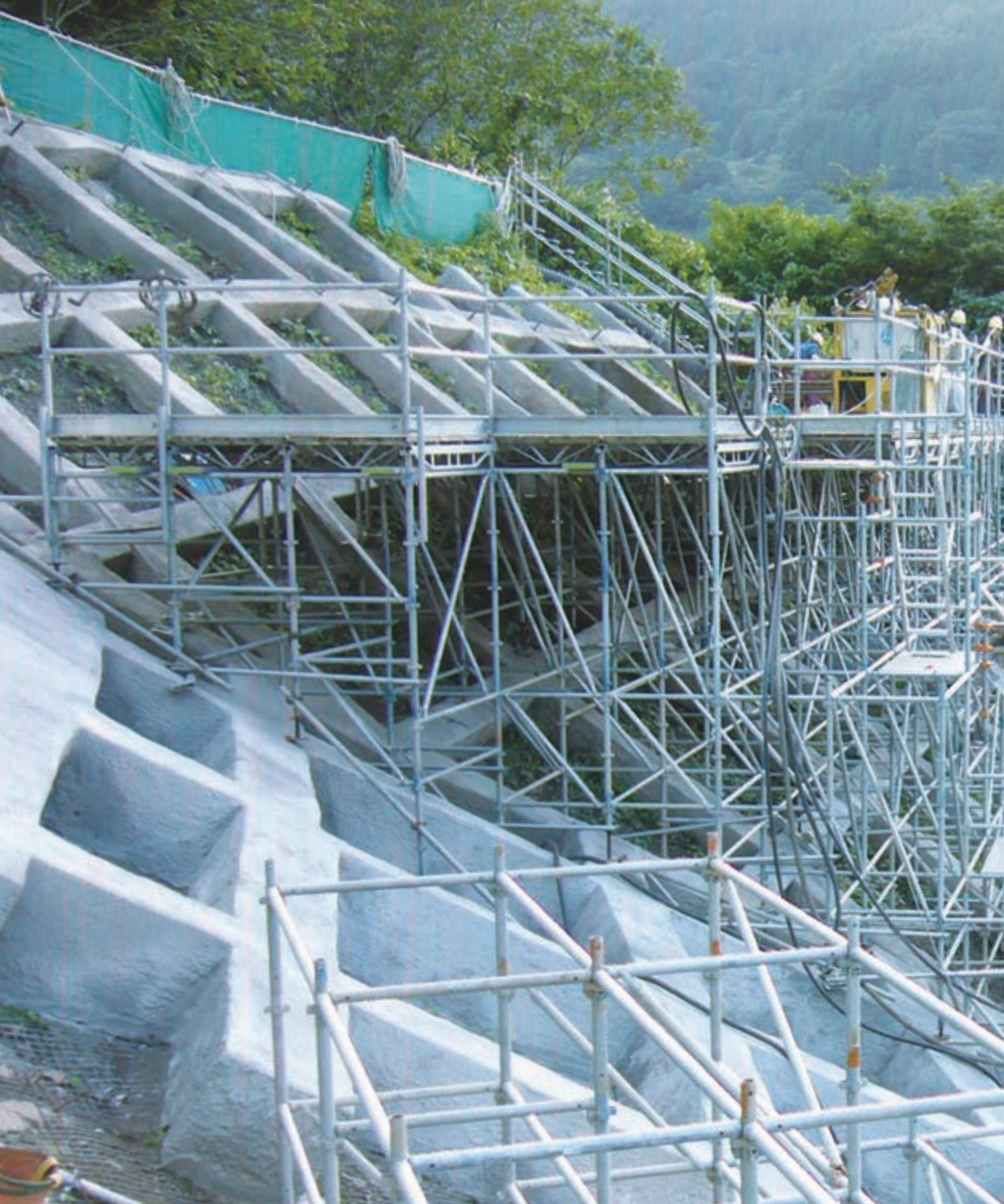
法面・支保工兼用とした、システム足場
