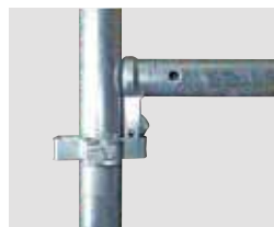
水平材の組立
