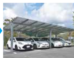
⑩ソーラーカーポート完成
