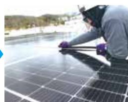
⑨止水ゴムガスケット設置
