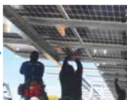
⑦太陽電池モジュール設置
