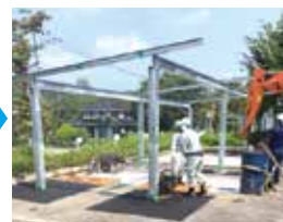
⑤アスファルト補修
