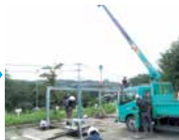
③支柱・梁組立
