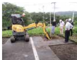
①位置出し、基礎掘削
