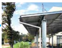
⑧雨樋設置
