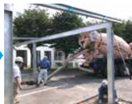
④基礎生コン打設
