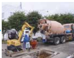
②捨てコン打設
