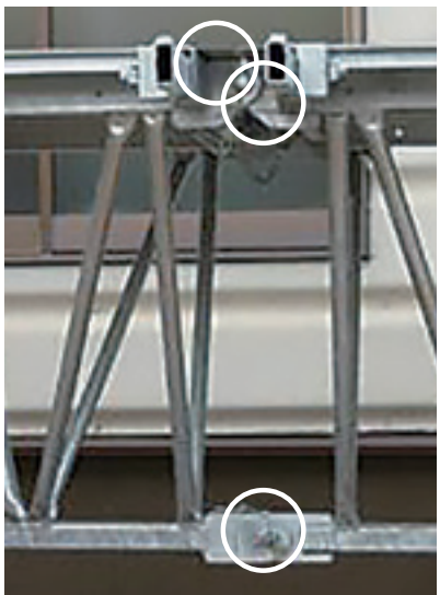
デッキ同士の連結 (ピンの固定は3箇所)
