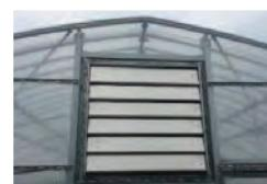
換気設備 換気扇・シャッター付
