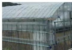
換気設備 側面2段巻上(手動)
