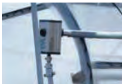
換気設備 谷換気・手動巻上
