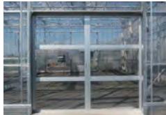
換気設備 出入口引分戸(アルミ製)
