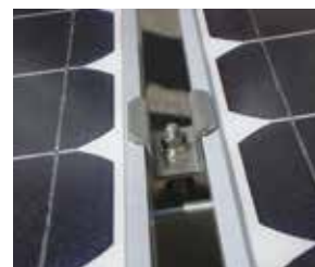
中間押え金具を取付け、2段目以降のモジュールを取付けていきます。
