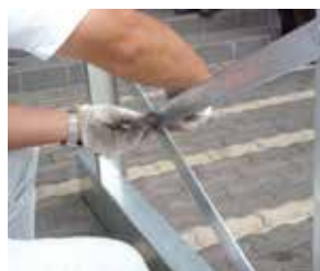
ブレースを取付けます。
