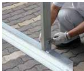
ベースレールにフレーム付支柱を取付けます。
