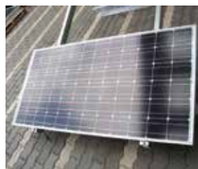
端部押え金具を取付け、1段目のモジュールを取付けます。
