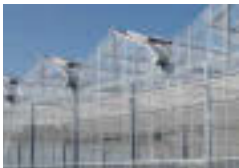
換気設備 片側全面天窓
