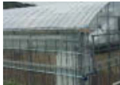
換気設備 側面2段巻上(手動)
