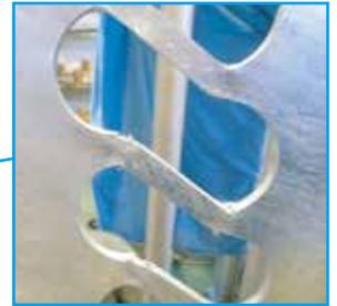
塑性変形により建物の振動エネルギーを吸収
