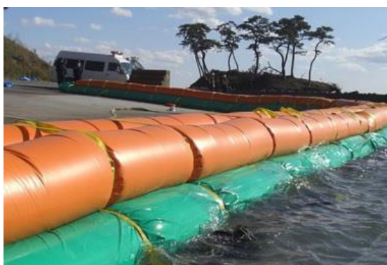
水害から守る『タイガーダム』
