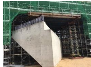
仮設材組立完了
