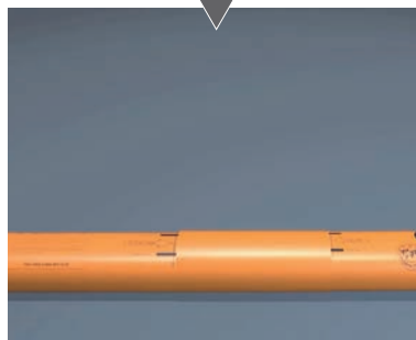
④ 注水し、設置完了
