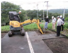
①位置出し、基礎掘削
