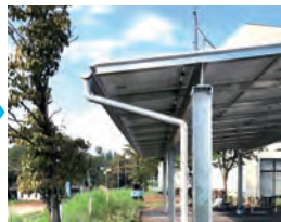
⑧雨樋設置
