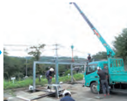
③支柱・梁組立
