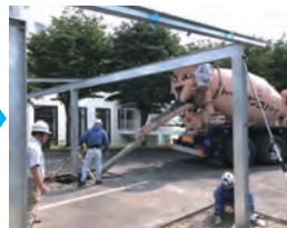
④基礎生コン打設
