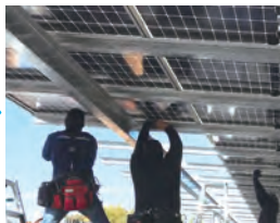
⑦太陽電池モジュール設置
