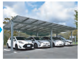
⑩ソーラーカーポート完成
