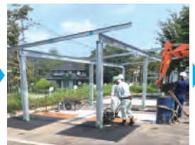
⑤アスファルト補修
