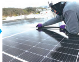
⑨止水ゴムガスケット設置
