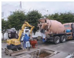
②捨てコン打設
