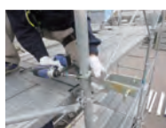
斜材受け金具の取り付け
