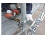
主材受け金具の取り付け
