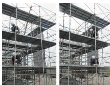
主材受け金具、斜材受け金具をクランプで取り付け
