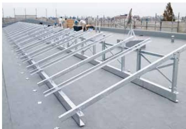
基礎工事、防水処理、敷地強度、架台強度等の個別の判断が必要とされる陸屋根架台。
