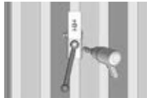
スパナ等でウルトラタイトを固定し、電動ドライバで固定して下さい。※ウルトラタイトの緩み、金具の傾き等を確認・修正してマーキングを行って下さい。
