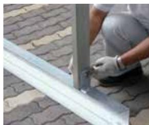
ベースレールにフレーム付支柱を取付けます。
