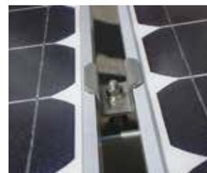
中間押え金具を取付け、2段目以降のモジュールを取付けていきます。
