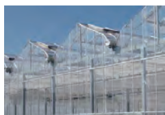
換気設備 片側全面天窓
