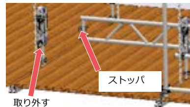
4.ビームのストッパをもとに戻し、吊り金具を取り外す
