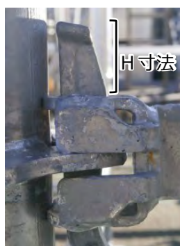
下部金具 くさび打ち込み時
