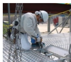
連結ボルトBの固定
